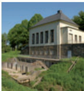
Pumpwerk Bönen Kleine Seske
