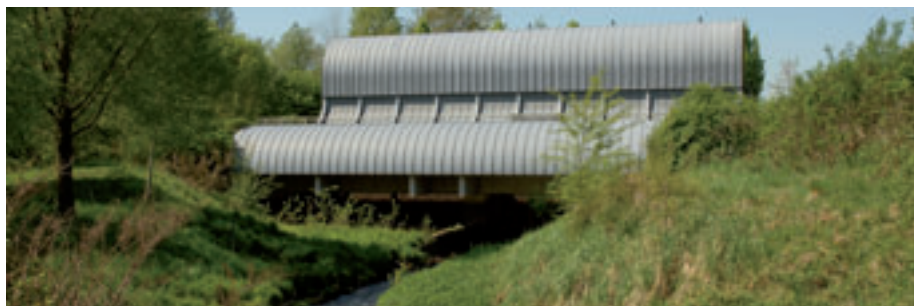
Pumpwerk Dorsten Hammbach
