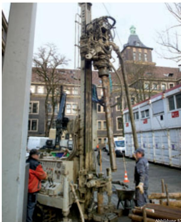
Bohrung für die Versenkung der Erdsonden auf dem Gelände der Emschergenossenschaft in Essen
